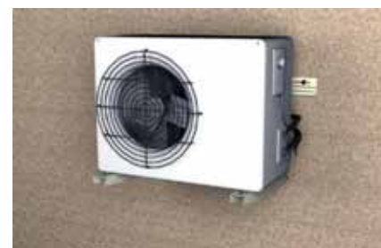
Condizionatori a parete
