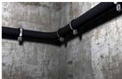
Fissaggio delle condotte in plastica
