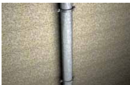
Pluviale a sezione circolare
