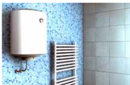
Scaldabagno a parete
