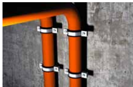
Fissaggio delle condotte in plastica
