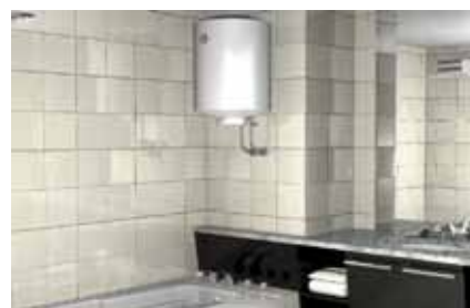
Scaldabagno a parete
